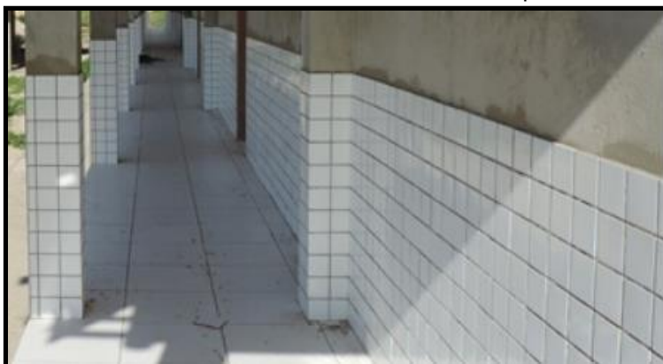
Imagem Ilustrativa: Parede com barrado impermeável
