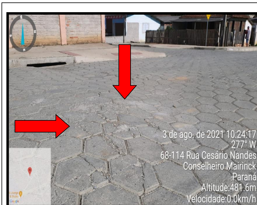
Foto 07 – Vista trecho Cesário Nandes – (Atualizada)
